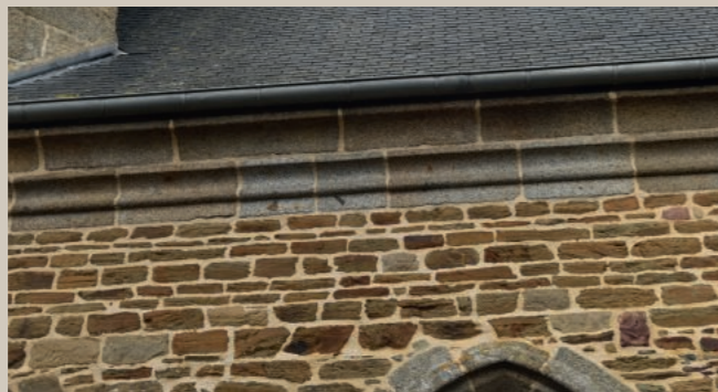
Corniche à double moulure au niveau de la façade sud.
